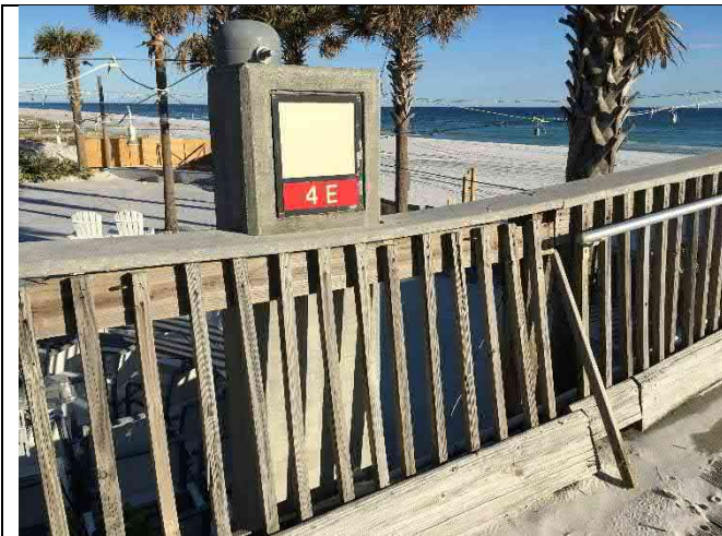
Bent 4E – Railing damage
