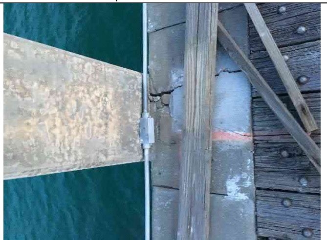
Bent 36E – Closure pour cracking and spalls
