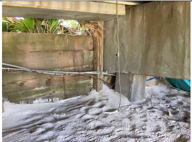
Bent 4E – Pile spall 6"x4"x1"
