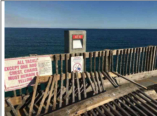
Bent 47E – Railing damage
