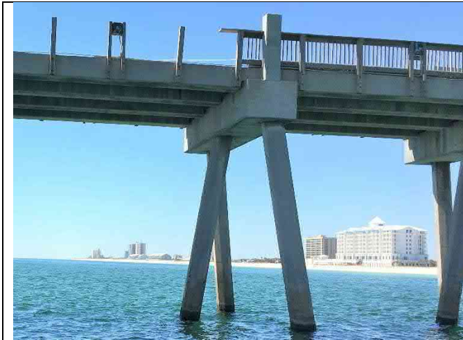
Bent 34E – Pile spalls 3x4~5"x5"x2"
