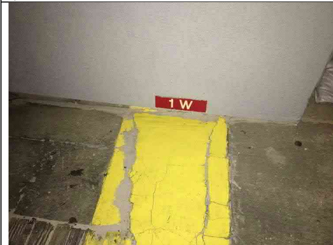
Bent 1W – Closure pour cracking (previous)
