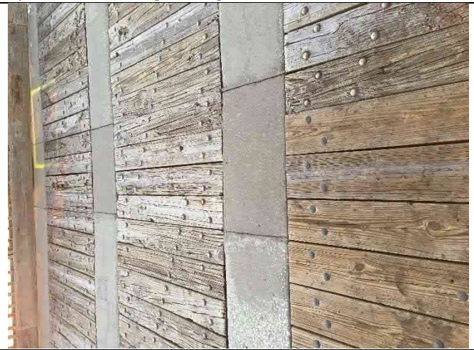
Span 39 – Closure pours
