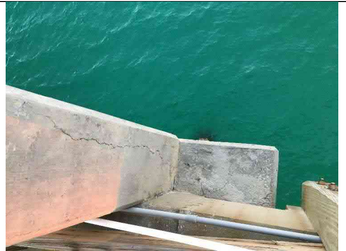
Bent 40E – Light column cracking (8' +/-)
