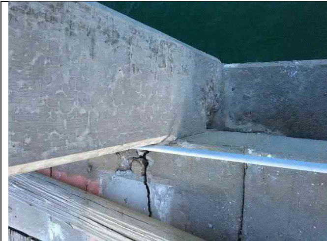
Bent 36E – Closure pour cracking and spalls
