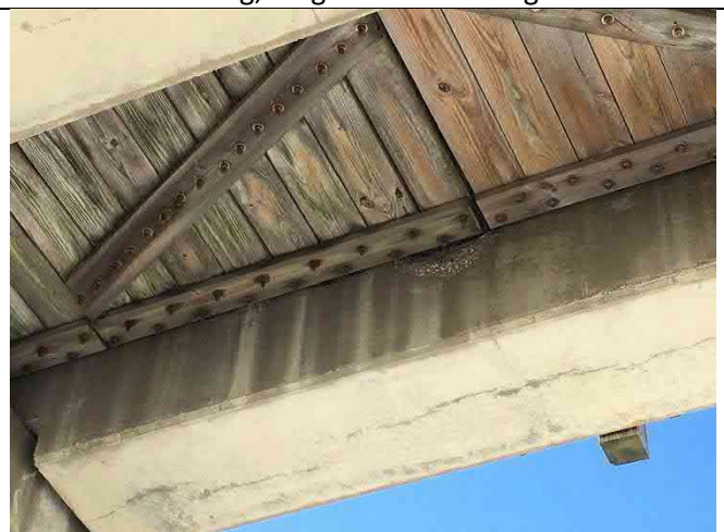
Beam 11-4 – Top flange spall 12”x8”x2”, longitudinal cracking
