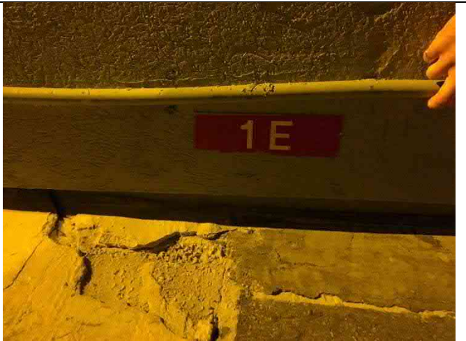
Bent 1E – Closure pour spall 18”x18”x1” (previous)
