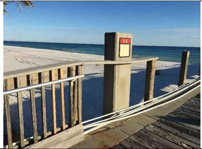
Bent 5E – Railing and conduit damage
